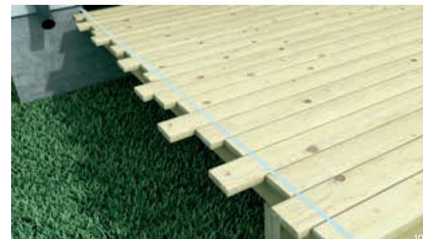
Når alle terrassebordene er montert, skal vi avmerke hvor de skal kappes. Terrassebordene skal stikke 1 cm utenfor terrassebjelkene. Bruk en krittspor til å markere hvor du skal kappe.
