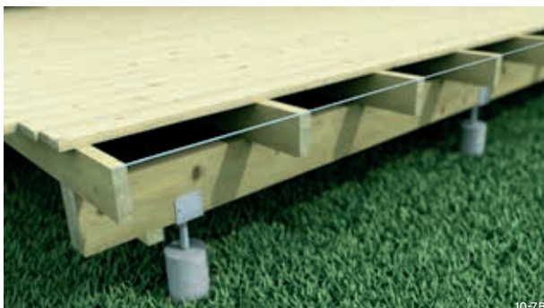
Merk av dette på alle terrassebjelkene. Bruk en krittspor og vinkel og kapp dem av.
