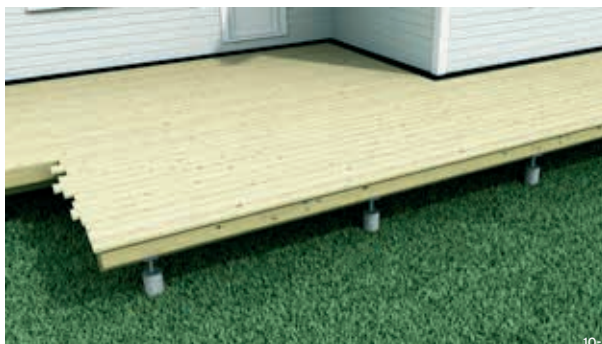
Monter så frontbordet. Her har vi valgt en 48x148, det samme som terrassebjelkene slik at det blir like avstander i hjørnene.
