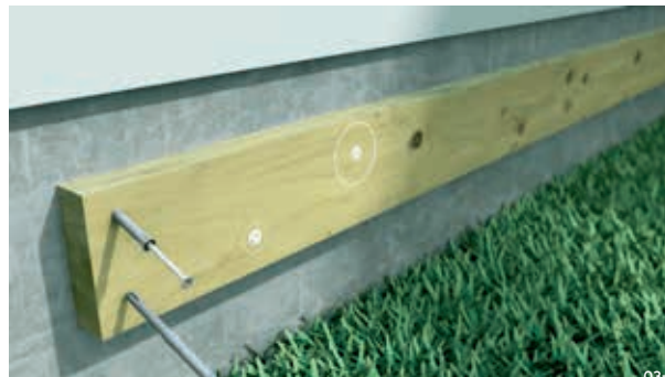
03-5 Sett en impregnert terrassebjelke, 48x148 mm, i underkanten av merket. Bruk laser så det blir vannrett. Fest med to skruer over hverandre i hver av endene og de andre i sikksakkmønster med et mellomrom på 60 cm.
