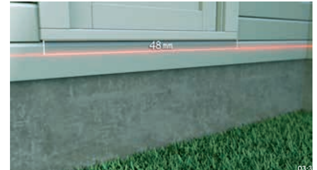
03-3 Skal terrassen gå rett ut fra terrassedøren, beregner du at terrassen skal være 20 mm lavere enn døren. Er terrassebordene 28 mm høye, markerer du en linje ca. 48 mm under døren. Det enkleste er å bruke et laservater.
