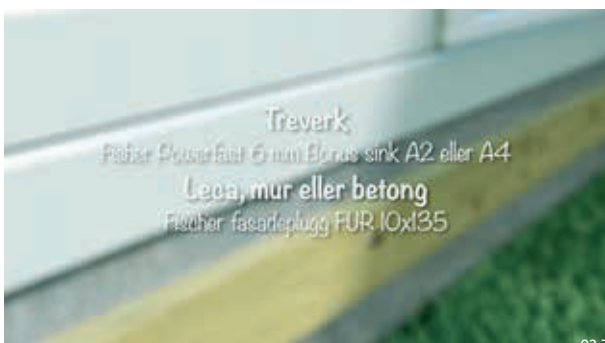
03-7 Fest bjelken. En tommelfingerregel er at 2/3 av skruen skal være inn i festet. Monters Selvbyggerstjeneste hjelper deg med å finne riktig skruer.
